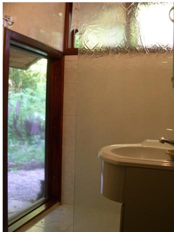
Painel de vidro fixo instalado no box do banheiro, substituindo a parede de vedação externa.
